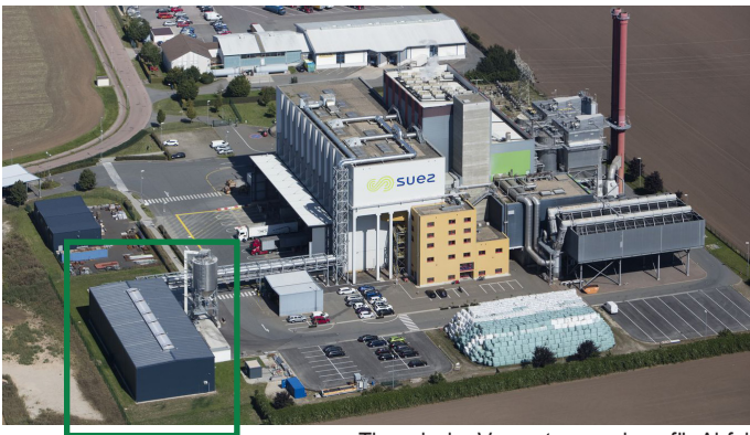
Thermische Verwertungsanlage für Abfall Grüner Kasten: Außenansicht des Trocknergebäudes mit Trockengut Silo
