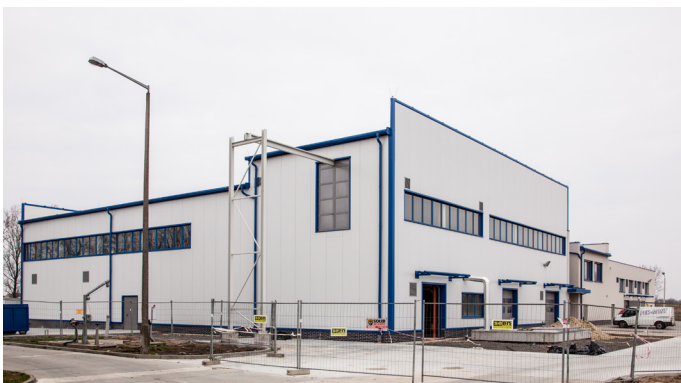
Außenansicht Gebäude Schlammbehandlung
