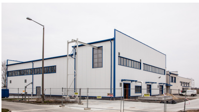
Außenansicht Gebäude Schlammbehandlung
