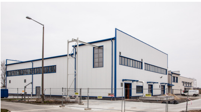
Außenansicht Gebäude Schlammbehandlung
