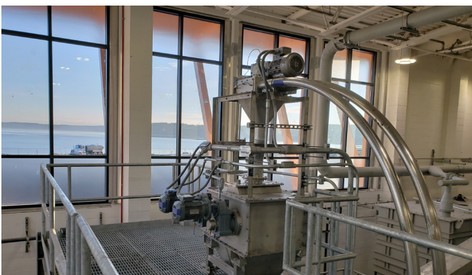
Rohrkettenträger (Trockenprodukt) zum Produktzerkleinerer
