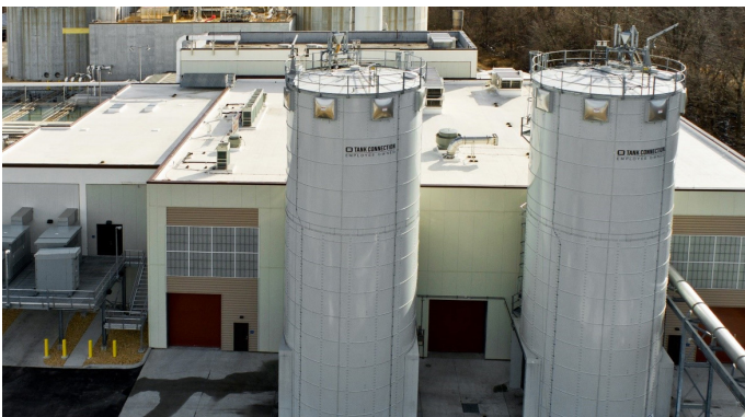
Außenansicht Trocknergebäude mit 2x Trockengutsilo
