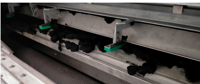
Dosierung rückgemischter Klärschlamm oberhalb der Rollenpresse
