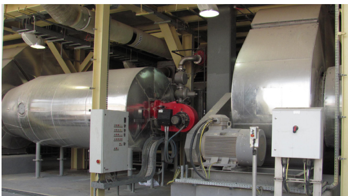
Brenner (rot) mit Brennkammer und Zuluftgebläse
