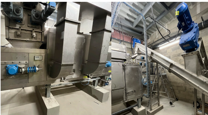
Links: Pilotrockner mit Aufgabeeinheit und Abluftkanälen Rechts: Produktaufgabe über Schneckenförderer
