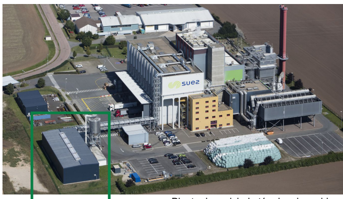
Planta de reciclado térmico de residuos Recuadro verde: Vista exterior del edificio del secadero con silo de material seco
