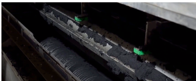
Unidad de alimentación con corredora de distribución y prensa de rodillos
