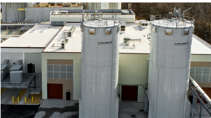
Vista exterior del edificio del secadero con 2 silos de material seco
