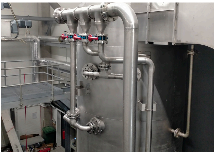
Precalentamiento de los lodos digeridos en columna en contracorriente con aire de escape húmedo y caliente del secador
