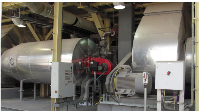
Quemador (rojo) con cámara de combustión y ventilador de aire de alimentación
