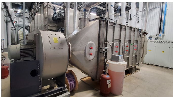
Ventilador de aire de impulsión con condensador horizontal con intercambiador de calor
