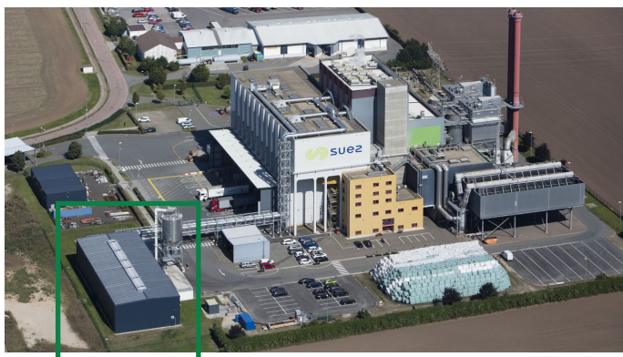
Installation de valorisation thermique des déchets Encadré vert vue extérieure du bâtiment du sécheur avec silo de matières sèches
