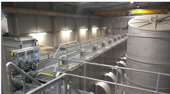
Sécheur à bande BD 3000/11 avec unité de distribution/dosage et condenseur
