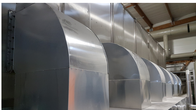
Sécheur à bande BD 3000/7 avec gaines d'évacuation d'air
