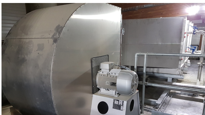
Ventilateur d'extractio d'air
