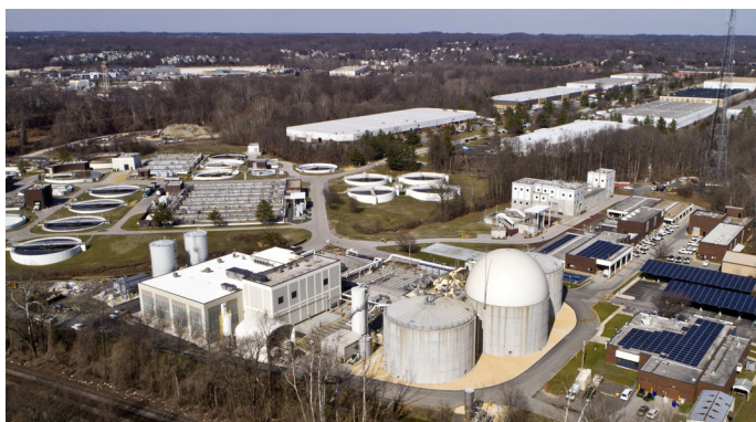
Usine de récupération d'eau de Little Patuxent (LPWRP)
