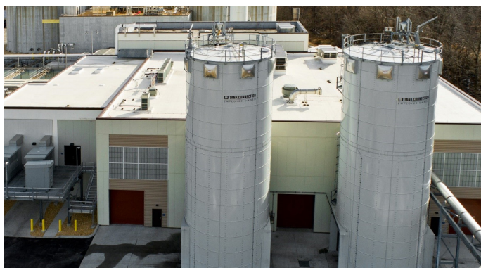
Vue extérieure du bâtiment du sécheur avec 2 silos de produits secs
