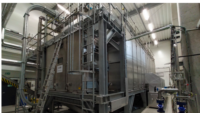
Sécheur à bande BD 3000/6 avec remixage
