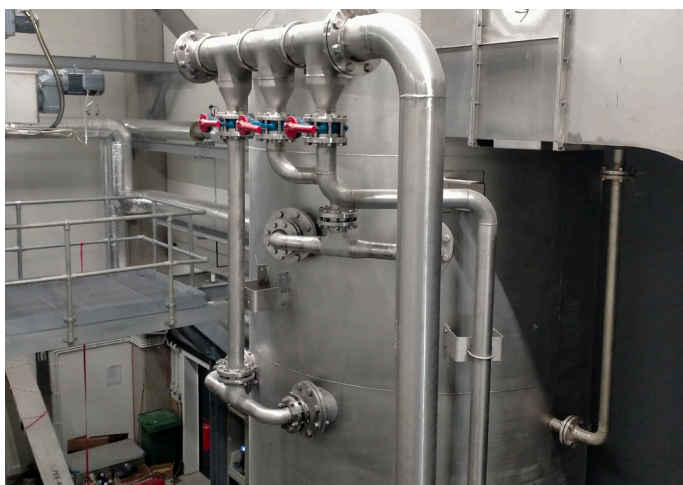
Préchauffage des boues digérées dans une colonne à contre-courant avec l'air chaud et humide du sécheur
