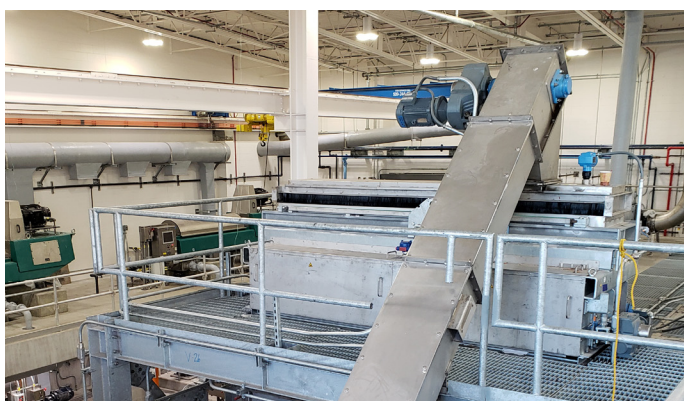
Convoyeur à chaîne (produit humide) vers l'unité d'alimentation (distributeur/doseur)
