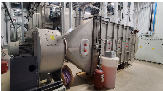
Soufflerie d'air d'alimentation avec condenseur horizontal avec échangeur de chaleur
