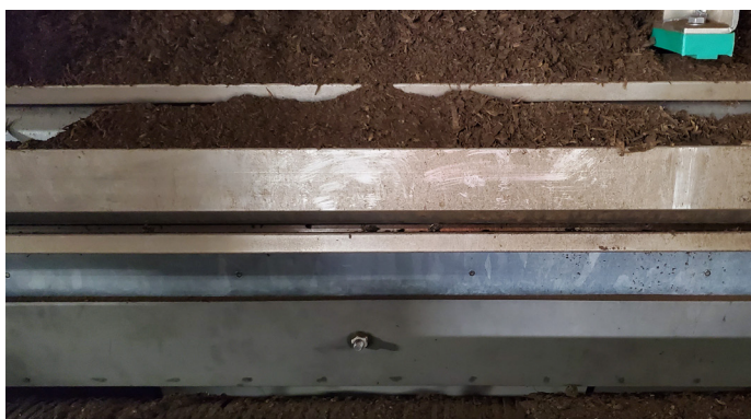
Matériau préséché au-dessus de la presse à rouleaux pour l'alimentation sur la bande supérieure du sécheur
